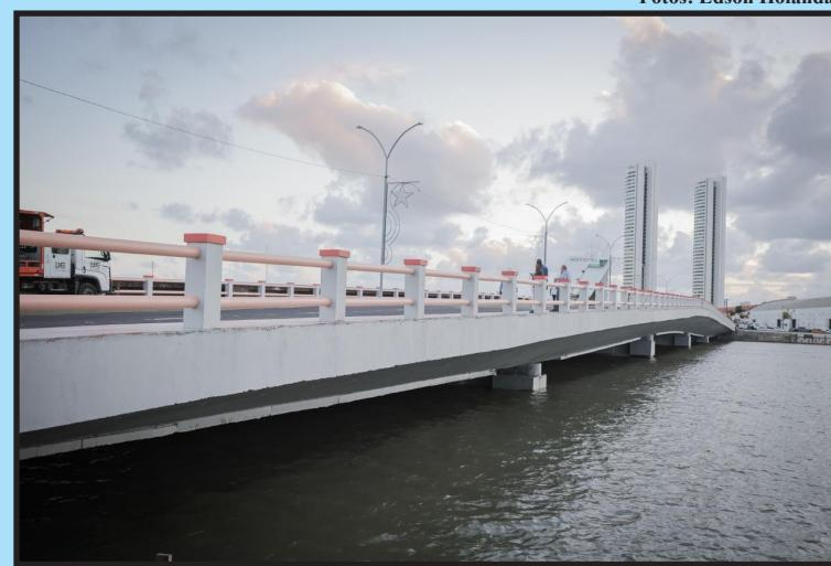
**ESPECIFICAÇÕES** - A Ponte Giratória tem uma extensão total de 195 metros com cinco vãos. É formada por um tabuleiro único, contínuo, com seção transversal tipo caixão ao longo de toda a sua extensão, possui transversinas e altura variável em cada apoio.
