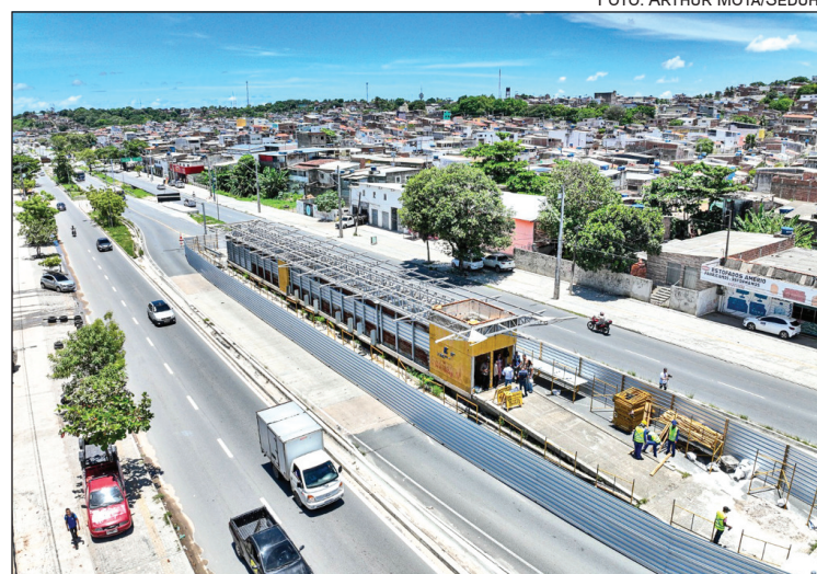
ESTAÇÃO Cidade Tabajara, na PE-15, em Paulista, foi a primeira a ter o canteiro de obras instalado
